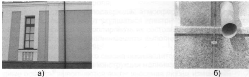
а) -монтаж по фасаду здания; б) -монтаж около водосточного слива (необходимо эквипотенциальное соединение)
